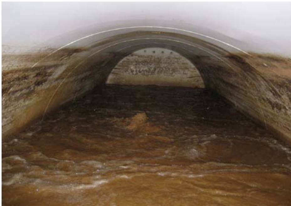
Loftblöndun skólps í gerjunartanki við Álver á Reyðarfirði. Ljós. Ketill Hallgrímsson.
