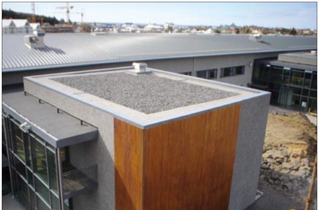
Lækjarskóli í Hafnarfirði. Hér má sjá þrenns konar þakkefni. - Bárujárn á efsta fletinum, þá PVC þakdúk undir möl og hellum og að lokum tjörupappa á mjóa fletinum.
