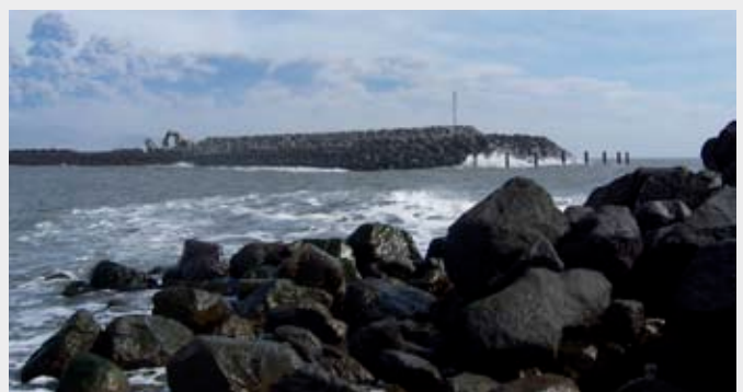
Landeyjahöfn verður varin með 600 metra löngum bogadregnum brimvarnargörðum úr grjóti. Hafnarmynnið verður 70 m breitt og inn af því 600 metra löng innsiglingarrenna. (Mynd: Bjarni Guðmundsson).
