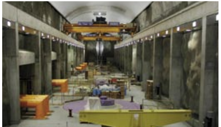
Séð yfir stöðvarhús Kárahnjúkavirkjunar.
